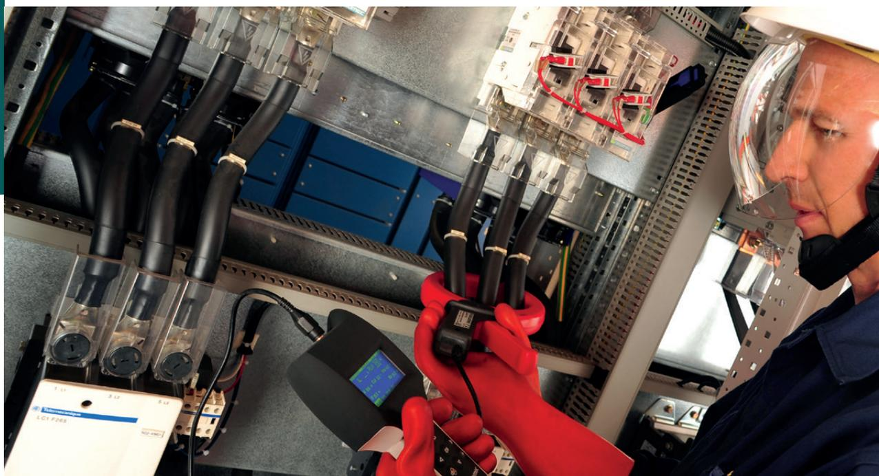
Nos experts se déplacent sur votre site et vous aident à contrôler le fonctionnement du contrôleur permanent d'isolement (CPI), pour mesurer l'isolement de votre installation et localiser les défauts jusqu'au niveau des alimentations/lignes en extrémité.
