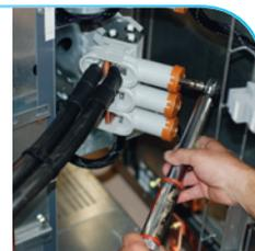
Exemple : Le marquage de l'écrou à l'aide d'un vernis acrylique teinté, indélébile et résistant en température permet :
