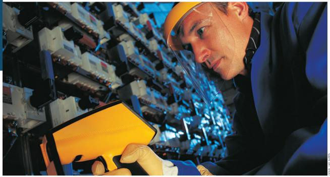
Le service d'imagerie thermique de Socomec prévoit le contrôle des composants de votre installation électrique au moyen d'un équipement spécial à infrarouges, pour assurer une analyse haute résolution pour la maintenance prédictive.
