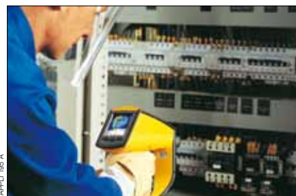
Контроль состояния электрораспределительных шкафов
